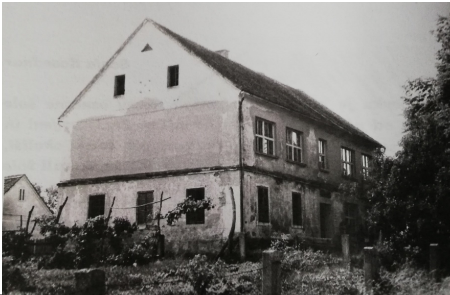
Zgradba šole iz leta 1873
